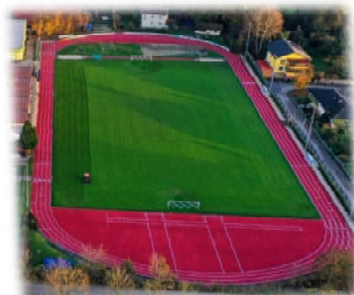
Unsere neu renovierte Anlage
