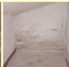
Feuchtigkeitssanierung mit Verputzarbeiten
