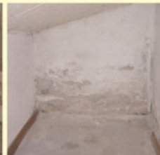
Feuchtigkeitssanierung mit Verputzarbeiten
