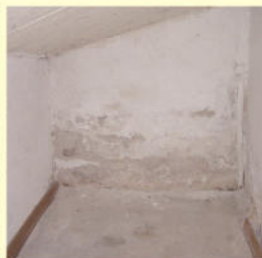
Feuchtigkeitssanierung mit Verputzarbeiten
