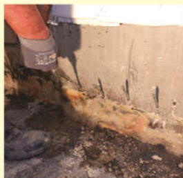
Mauertrockenlegung
