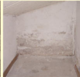
Feuchtigkeitssanierung mit Verputzarbeiten
