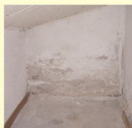
Feuchtigkeitssanierung mit Verputzarbeiten
