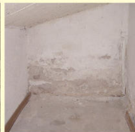
Feuchtigkeitssanierung mit Verputzarbeiten
